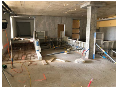
Der Höhenunterschied wird rollstuhlgängig betoniert.
