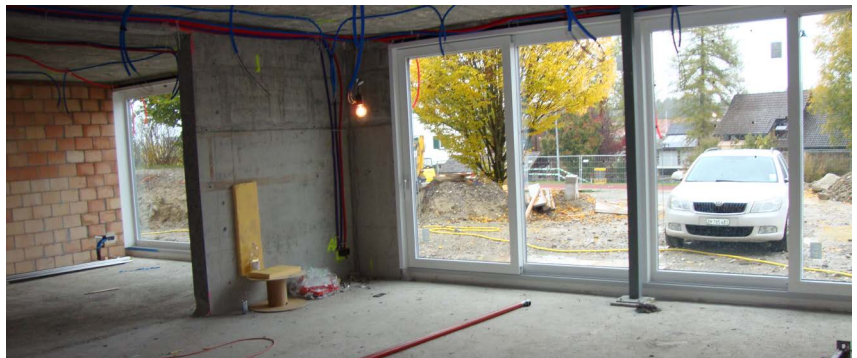
Der Esssaal mit bereits eingebauten Fenstern im Rohbau
