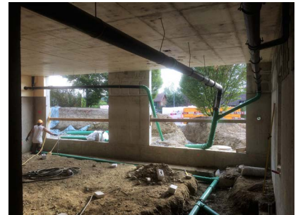
Die Kanalisation wird ein Stockwerk tiefergelegt.
