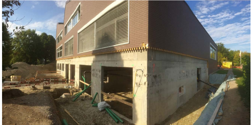
Freigelegte Kellerwände mit den Aussparungen für die Fenster.
